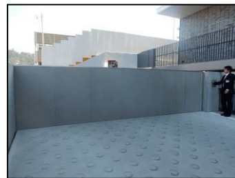
兵庫県洲本市 津波対策バリケード
