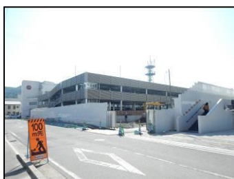
兵庫県洲本市 立体駐車場（建設中）
