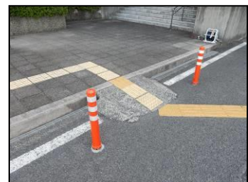
駐車場から庁舎入口への 車イス等アプローチ
