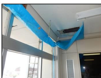
本庁舎 天井の漏水対応
