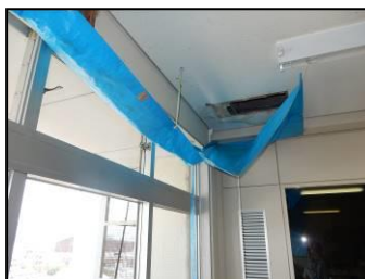
本庁舎 天井の漏水対応
