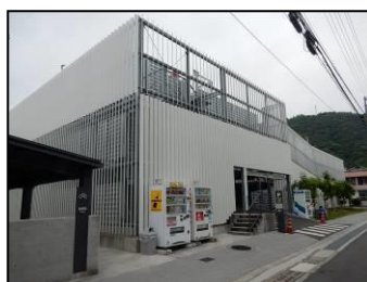
高知県のいの町 立体駐車場
