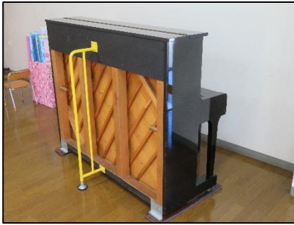
非構造部材の耐震補強 ピアノの転倒防止
