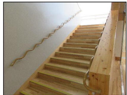
歩行しやすい階段手摺の設置
