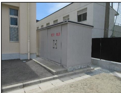
備蓄倉庫の設置
