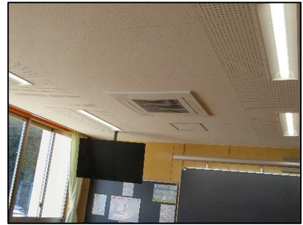
エアコンの設置
