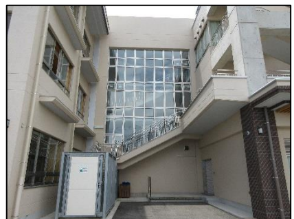
屋上を避難場所として有効活用
