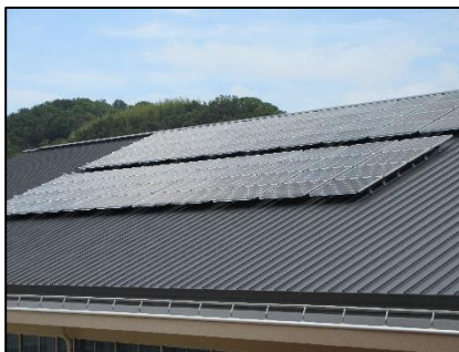
太陽光パネルの設置
