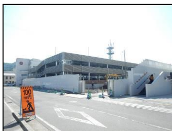
洲本市 立体駐車場（建設中）
