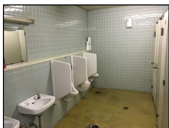
本庁舎 トイレ
