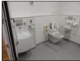
新宮市 障がい者用トイレ
