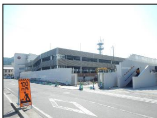
兵庫県洲本市 立体駐車場（建設中）
