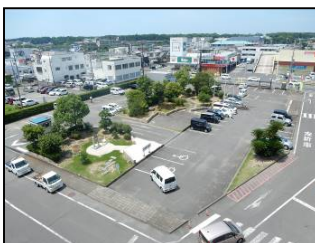
来客用駐車場 庁舎と駐車場を 隔てる車道
