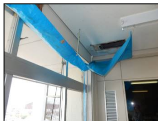
本庁舎 天井の漏水対応
