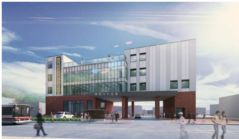
◆図4：浸水対策を施した市町村庁舎の例（ピロティ形式及び建物1階にホール機能等を設置、北海道古宇郡神恵内村）
