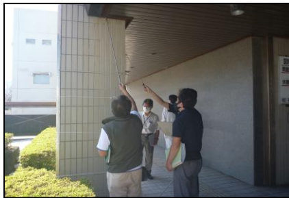
図表 4-8：施設点検実地研修会の様子（打診棒で外壁タイルの浮きを確認）
