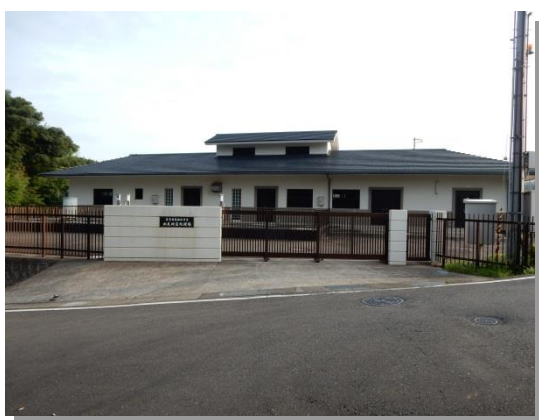
加尾地区処理場
