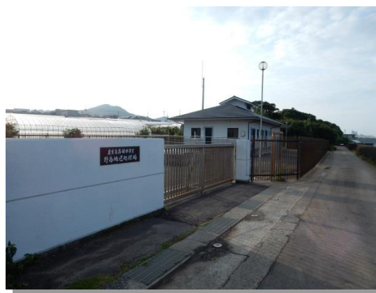
野島地区処理場
