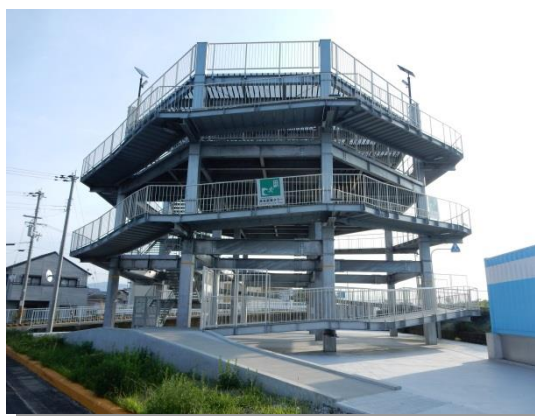
菟津波避難タワー
