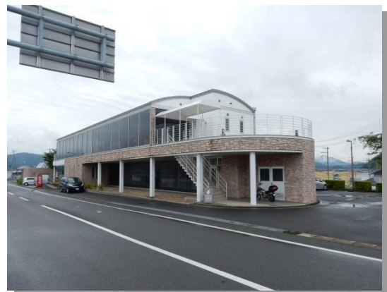
ふれあい水辺公園管理事務所 管理棟
