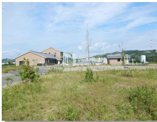
塩屋浄化センター
