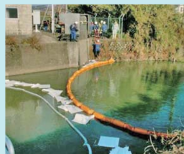
▲油の除去作業の様子
