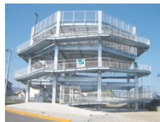
▲津波避難タワー
