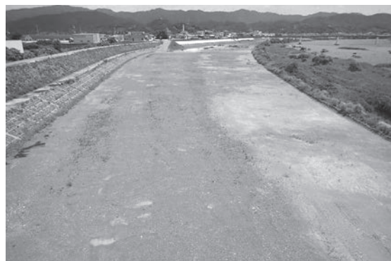
野口新橋から（上流側を望む）
