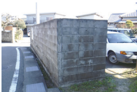
【ブロック塀撤去前】
