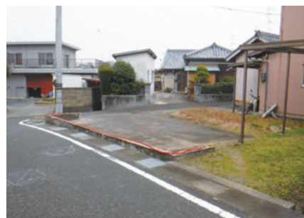
【ブロック塀撤去後】
