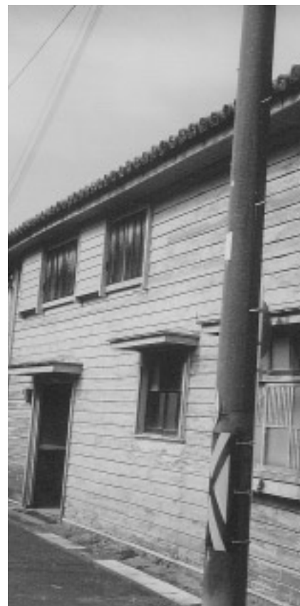
“新町”の通りには鎧張りの洋館が多い。
