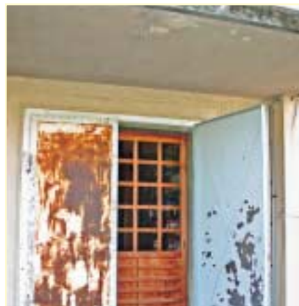
玄関入口。鉄製扉を観音開きに開けると中に木製扉がついている。
