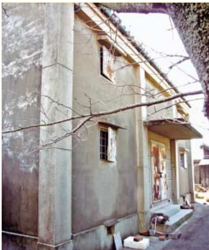
洋風の蔵 柱型を現し、入口上部に庇も見られる。
