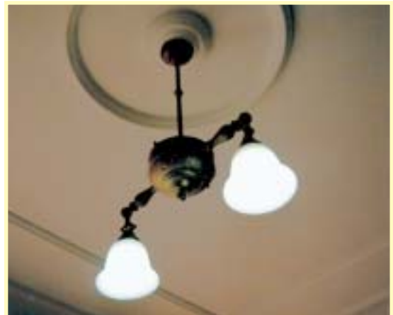
漆喰で仕上げた天井に吊り下げられた照明器具
