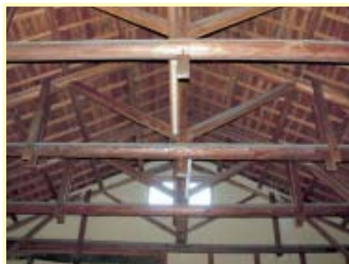
屋根をトラスに組んだ棟
