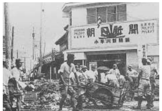
水害復旧作業 上/松原通り 下/大浜通り
