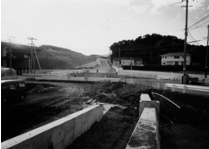
市道野口熊野線工事のようす
