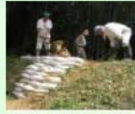
漏水箇所の補修
