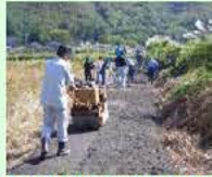
未舗装農道の舗装
