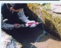
水路のひび割れ補修
