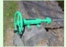
ゲート、バルブの更新
