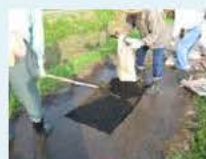
農道の部分補修
