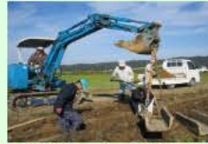
コンクリート水路の更新
