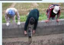
施設の機能診断
