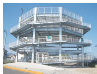
▲津波避難タワー
