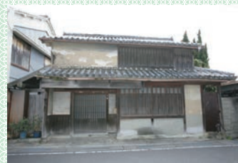
④ 大黒屋 津本家 昔なつかしい手動ポンプが残る
