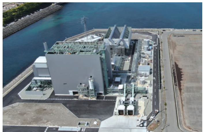
和歌山御坊バイオマス発電所
