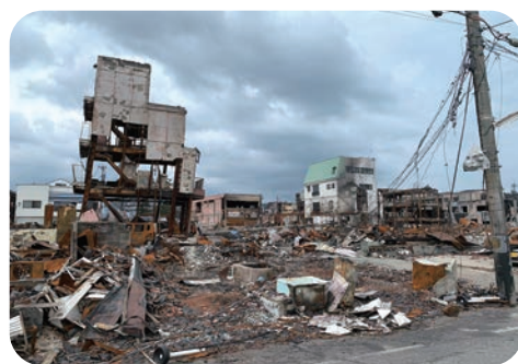
被害を受けた輪島市の様子
